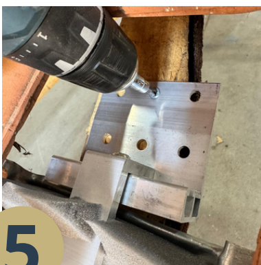
Dachhaken montieren
