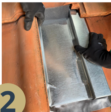
Blechziegel von einsetzen
