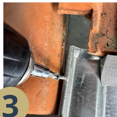
Blechziegel mittels Dichtschraube auf den Dachlatten befestigen
